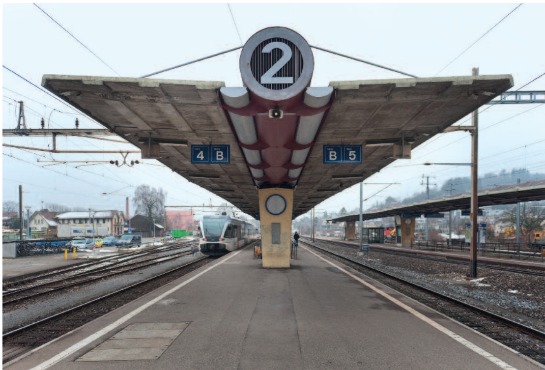
50er-Jahre am Bahnhof Grütze: Die einzigartigen Rohr- träger-Perrondächer wurden 1955 vom Archi- itekten Hans Hilfiker als Prototypen erstellt.
